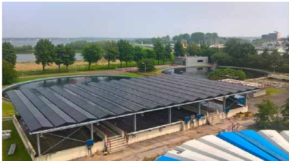
4.19 Rioolwaterzuivering bieden kansen voor terugwinning van restwarmte en vormen ruimtelijk logische aanleidingen voor het plaatsen van opstellingen voor het opwekken van duurzame energie
