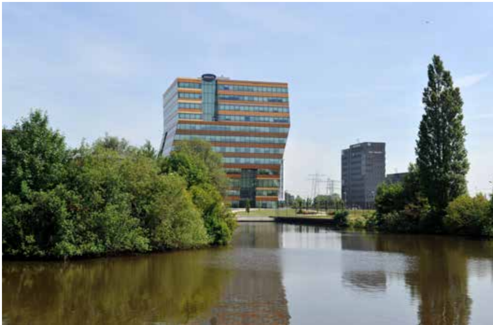
2.60 Een deel van de energie-opgave kan binnen de stad worden opgelost; met besparen, zon op dak, op parkeerterreinen en in wachtlandschappen. Kantoor- en bedrijventerreinen hebben veel potentie om hieraan bij te dragen
