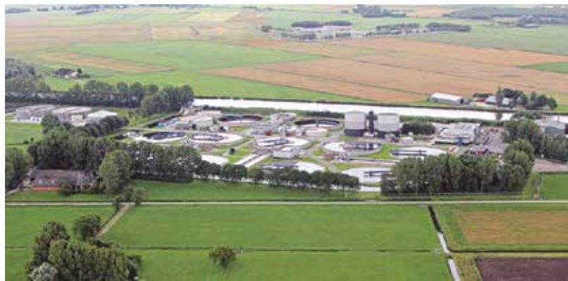
3.21 Zicht op RWZI Garmerwolde, de grootste rioolwaterzuiveringsinstallatie van Noord-Nederland
