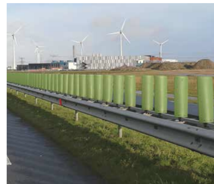
3.23 Rond Eemshaven ontstaat een grootschalig energiecluster waar veel aanbod (wind op land, wind op zee), veel vraag (bijv. datacenters) en het hoogspanningsnet samen komen
