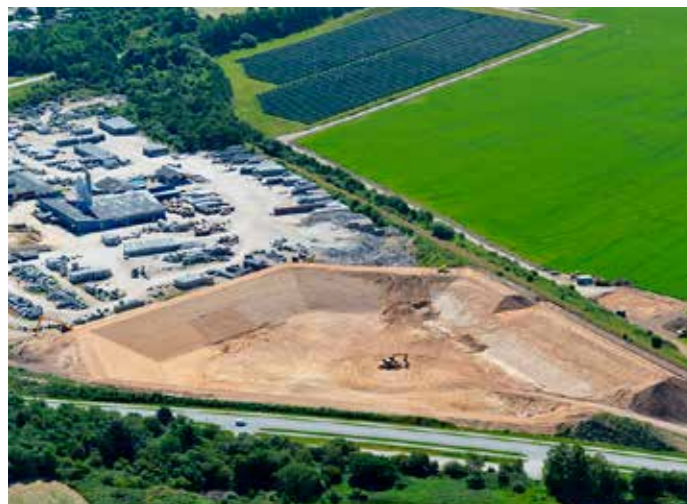
2.11 Een collectieve warmtevoorziening (groot heet waterbassin dat door zonne-energie verwarmd wordt) in aanbouw in Vojens, Denemarken
