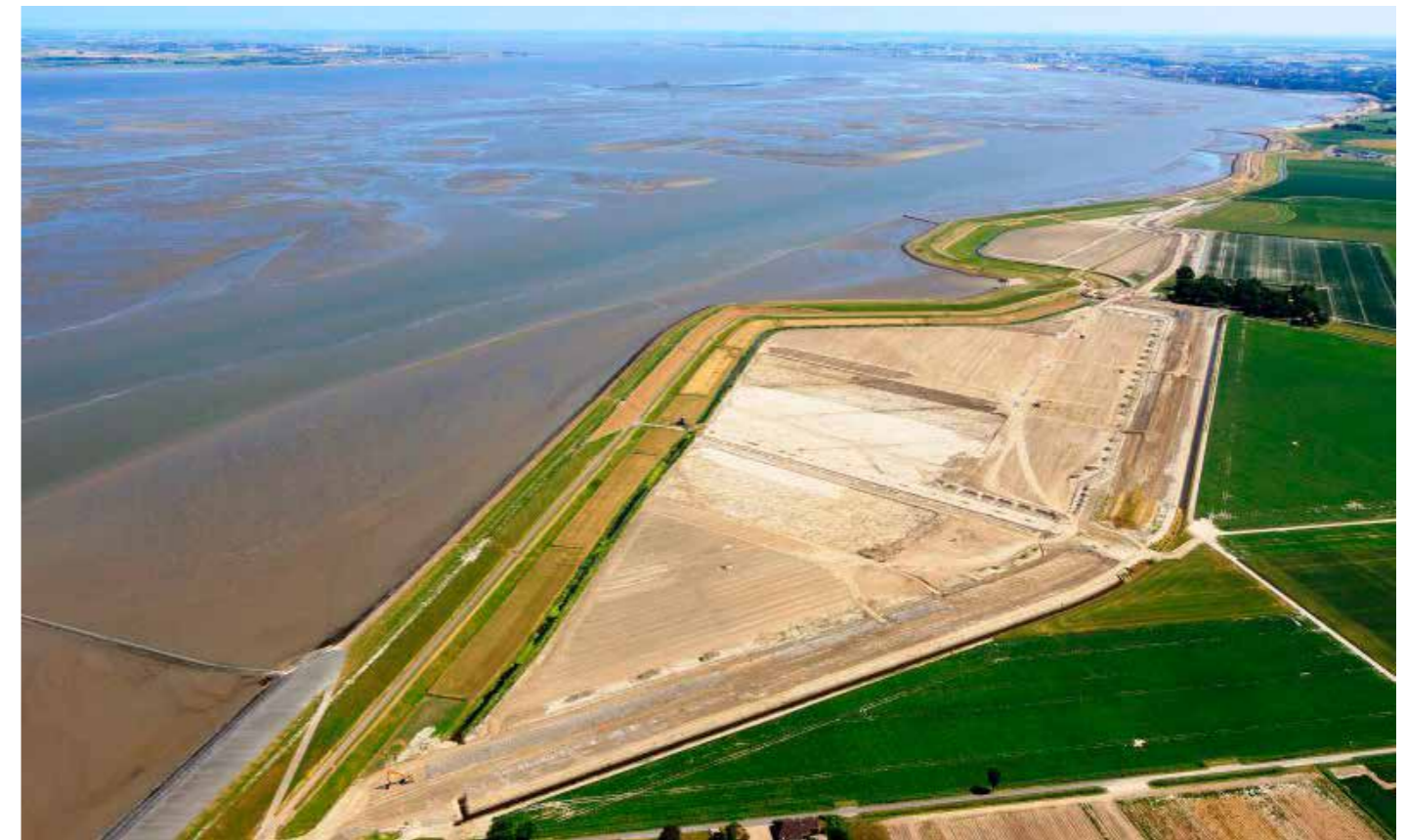
4.1 De dubbele dijk, onderdeel van de dijkversterking Eemshaven-Delfzijl, maakt de kustbescherming hier toekomstbestendig. De zone tussen de twee dijken is middels een getijdenduiker verbonden met het buitenwater, waardoor water in en uit het tussengebied kan stromen. Dit levert een bijdrage aan het oplossen van het slibprobleem in de Dollard en biedt het kansen voor natuurontwikkeling en zilte landbouw. Door de verbinding te zoeken tussen verschillende opgaven ontstaan er meervoudige oplossingen. Ook vanuit energie is het mogelijk de verbinding te zoeken met andere opgaven.
