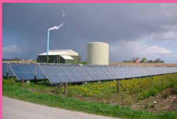
2.42 Kleinschalige collectieve warmtevoorziening: met o. a. zonneboilers en aangesloten op een lokaal warmtenet (Denemarken)
