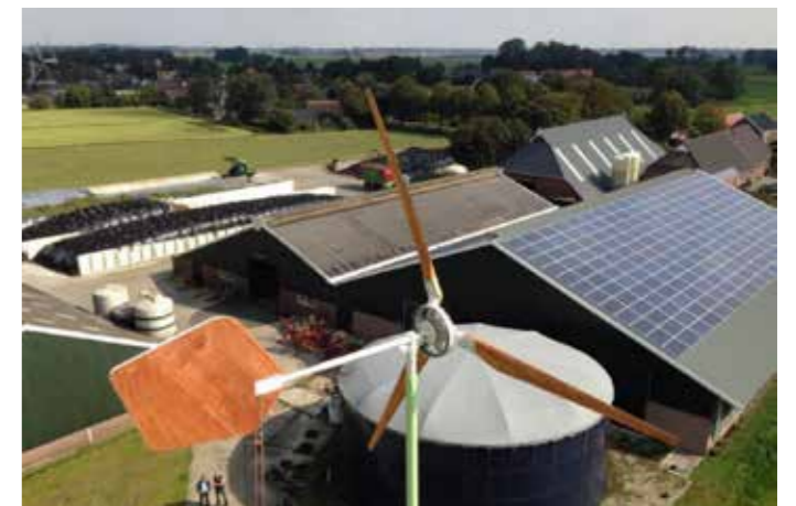
2.17 Groninger erf als 'energie-fabriek' windenergie van een turbine, zonne-energie van het dak en biogas uit de mestvergister
