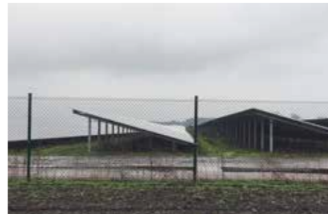
3.10 Zonnepark Midden-Groningen met een vermogen van 103 megawattpiek
