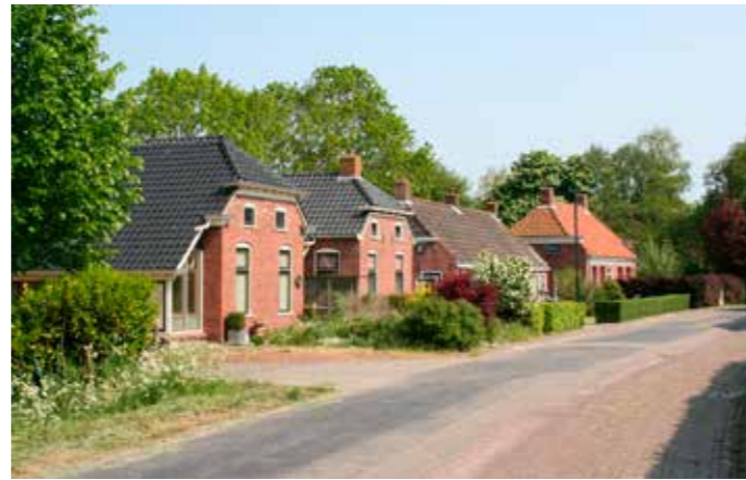
2.31 Dorpsgezicht Lellens. De oude woningen bieden vaak weinig mogelijkheden voor plaatsing van zonnepanelen. De grote schuren op de erven eromheen des te meer
