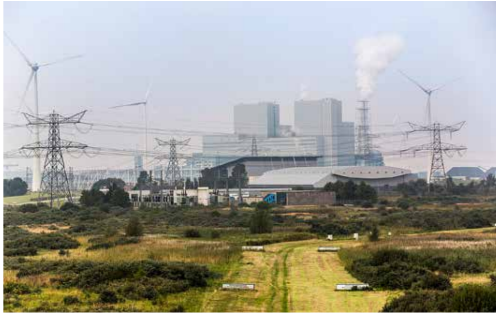
3.3 Het huidige hoogspanningsnet is ingericht op de distributie vanuit centrale opwek op een paar locaties, zoals bij de Eemshavencentrale. De omschakeling naar hernieuwbare energie vraagt ook de nodige aanpassingen van het elektriciteitsnetwerk
